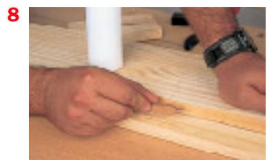
**1. Tracer sur la pièce A l'épaisseur de la pièce B. Ici, on utilise deux planches de sapin.**
